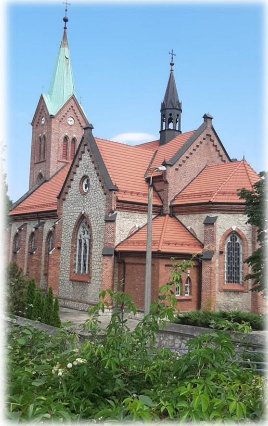
Fot. 23 Widok na kościół św. Elżbiety Węgierskiej w Szczakowej.
