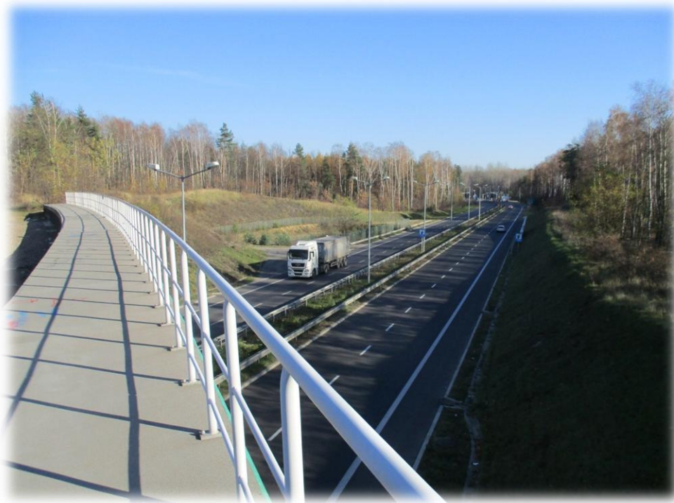
Fot. 69 Bezpieczna przeprawa nad DK 79.
