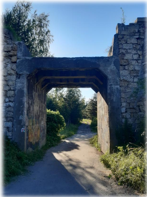
Fot. 16 Dawny most kolejowy w Długoszyńcu.
