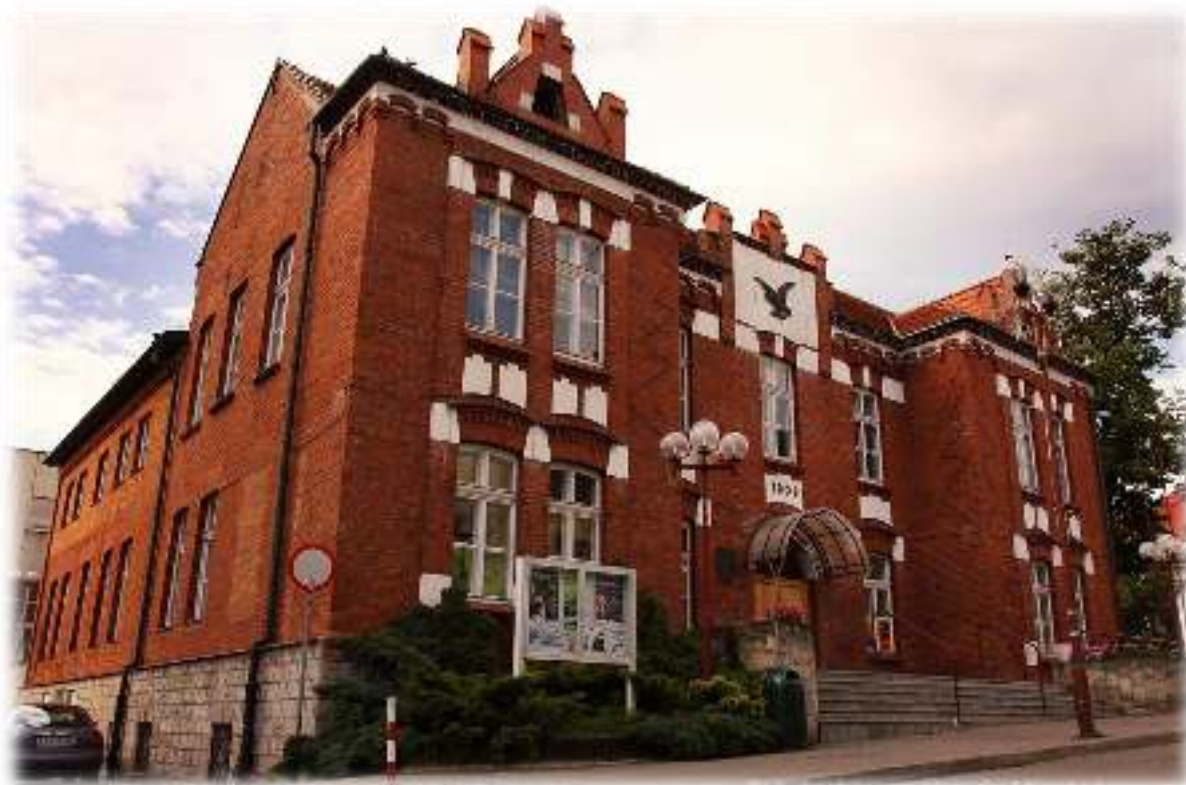
Fot. 79 176 Dawny budynek TG „Sokół”.
